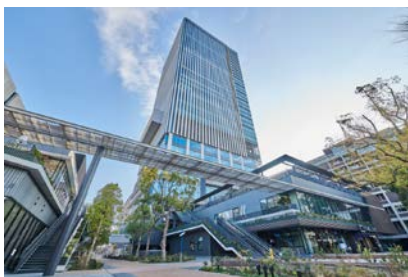
BASEGATE横浜関内タワー
