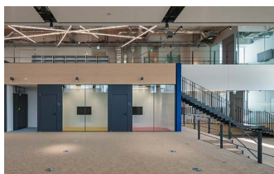
2階事務室エリア 床吹出し空調+躯体蓄熱
