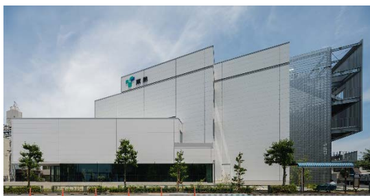
東熱技術開発センターの外観
