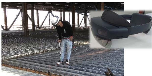
HoloLens2を着用し、立ったままマーキングができるスタンプ型により腰への負担を軽減
