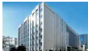
日本大学お茶の水総合開発（第2期） のうち歯学部新校舎新築工事
