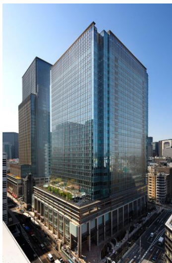
日本橋室町三井タワー
