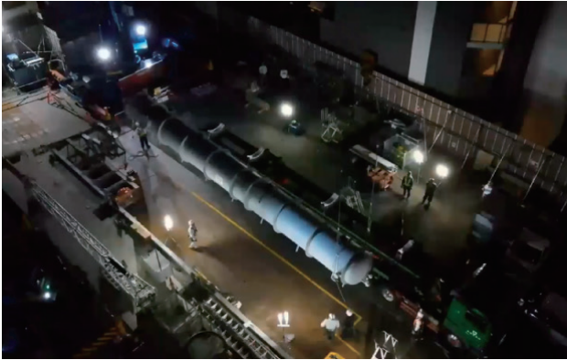
写真4 縦型蓄熱層 搬入状況
