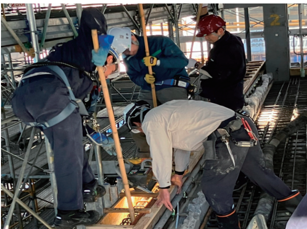
写真5 RC壁打設状況
