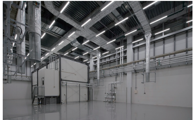
写真7 大実験室配管・ダクト・ラック施工後
