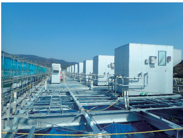
写真7 空調機ユニット据付完了
