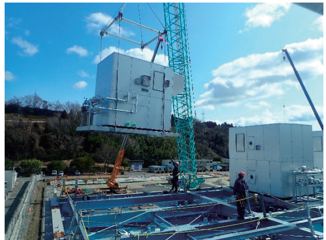
写真5 空調機ユニットの揚重状況
