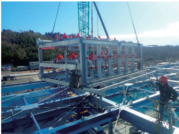
写真6 一斉開放弁ユニットの揚重状況
