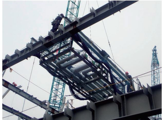
写真3 屋上配管ユニットの揚重状況
