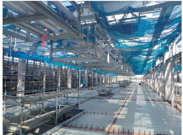
写真4 屋上配管ユニット据付完了
