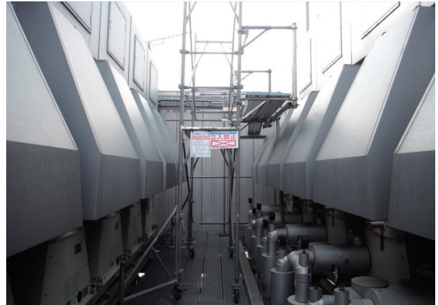
写真4 チラーへの取付作業用ローリングタワー
