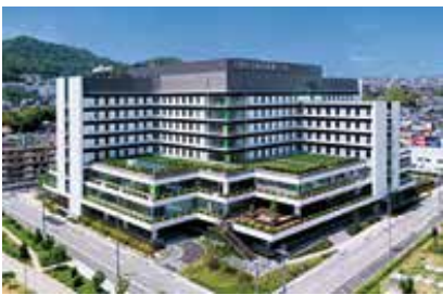
川西市立総合医療センター
